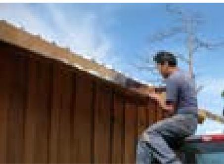
**CANALETAS.** También son de lámina galvanizada y se fijan al techo con remaches. Sirven para conducir el agua que escurre del techo hacia los componentes de filtrado. Mantenimiento: se recomienda limpiar con frecuencia las hojas, tierra e insectos que puedan acumularse.
